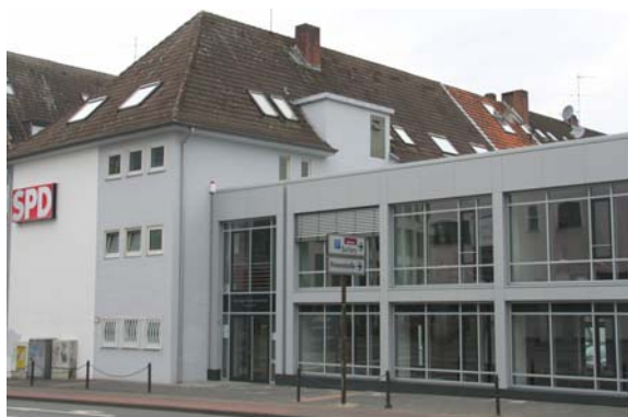
Das „Hans-Jürgen Wischnewski Haus“ in der Magnusstraße: die komplett umgebaute Heimstätte der KölnSPD mit neuer Außenfassade. (Beiträge zur Eröffnung ab Seite 4)
