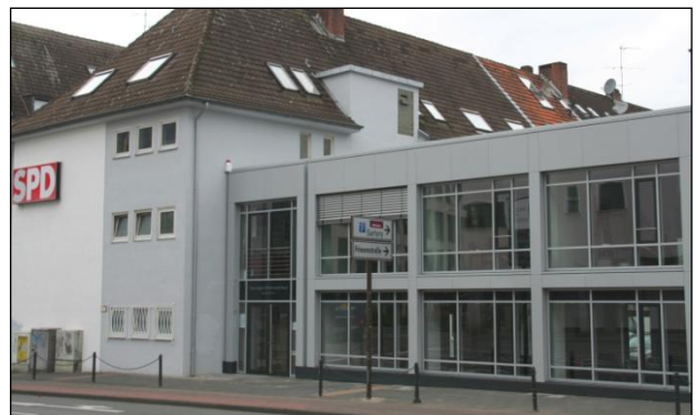
Das Kölner MdB-Büro ist im Hans-Jürgen Wischnewski- Haus untergebracht
